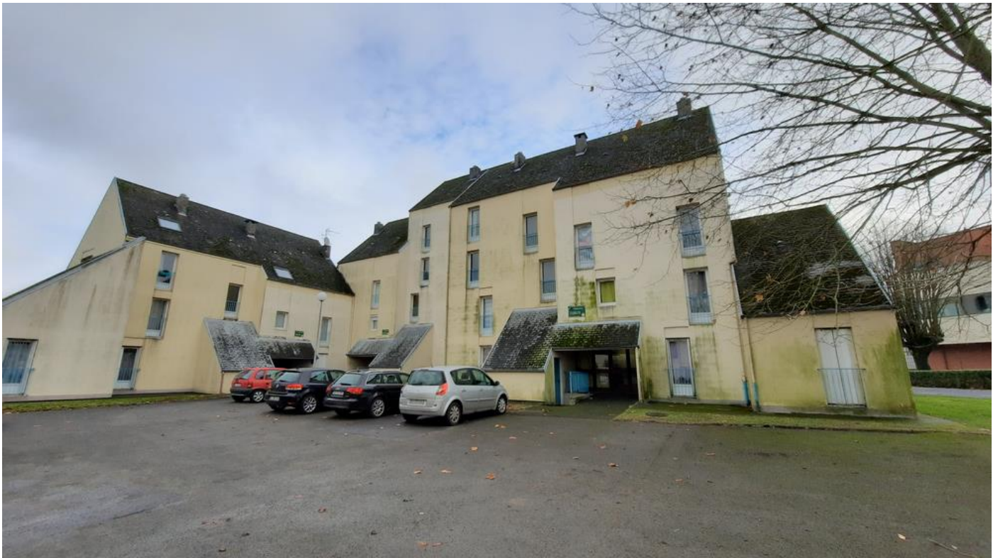
Photo des 3 résidences Anémones, Bleuets et Coquelicots ( Façade ouest)
