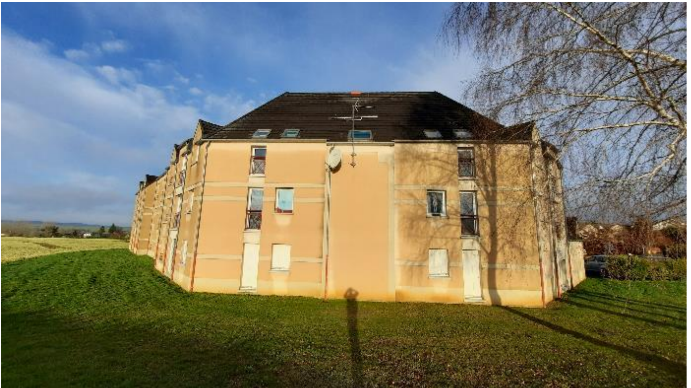
Résidence L Armstrong , vue arrière de façade d'une longueur de 90 mètres coté champ sans aucun nid
