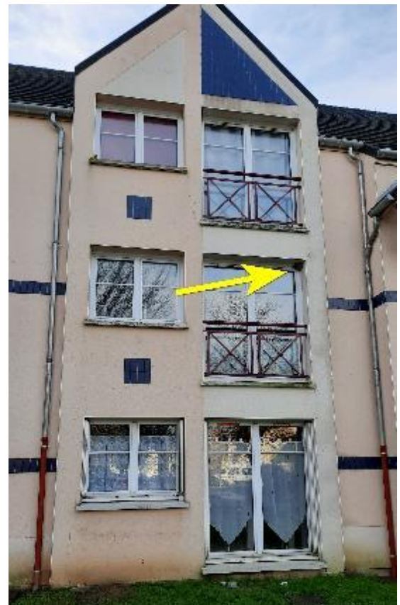
1 seul nid dans un angle de fenêtre sur la façade avant à gauche de l'entrée
